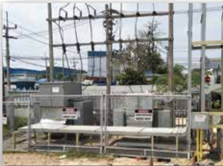
ติดตั้งหม้อแปลงไฟฟ้า
