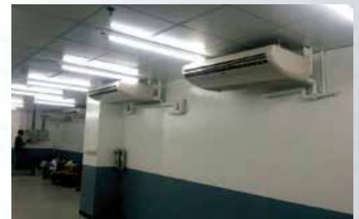
ระบบเครื่องปรับอากาศแบบแยกส่วน (ขนาดเล็ก)
