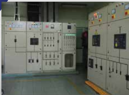
ติดตั้งตู้ MAIN DISTRIBUTION BOARD (MDB)
