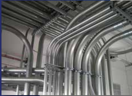
การติดตั้งงานท่อร้อยสายไฟ
