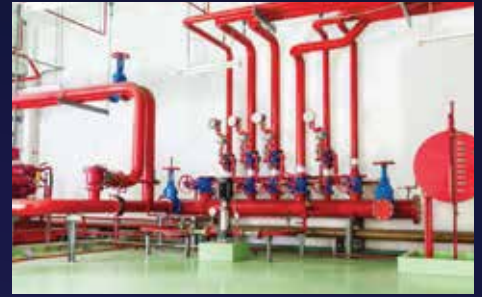
งานติดตั้งระบบดับเพลิง (SPRINGER SYSTEM)
