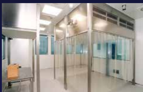
งานติดตั้งห้องควบคุมความชื้น (HUMIDITY CONTROL SYSTEM)
