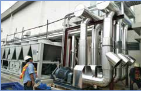
งานระบบปรับอากาศ (INSTALL CHILLER)
