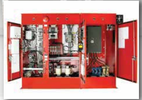
งานติดตั้งระบบ FIRE ALARM
