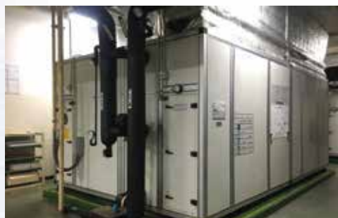
งานติดตั้ง AHU
