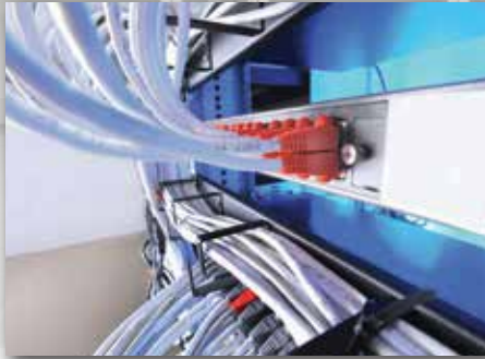
งานติดตั้งสายคอมพิวเตอร์
