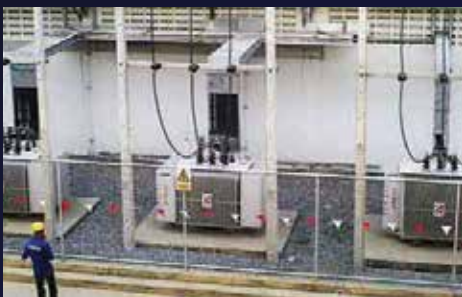
งานติดตั้งหม้อแปลงไฟฟ้า (INSTALL TRANSFORMER)
