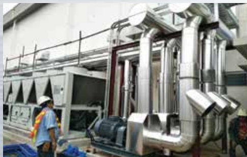
งานติดตั้ง CHILLER
